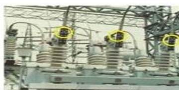
شکل ۳ - نمونه‌هایی از مواد ترموکرومیک؛ تغییر رنگ به دلیل تفاوت دمای بخش‌های مختلف دست و تغییر رنگ تخت خواب و سنسورهای مورد استفاده در ترانس‌های برق و قطارها
